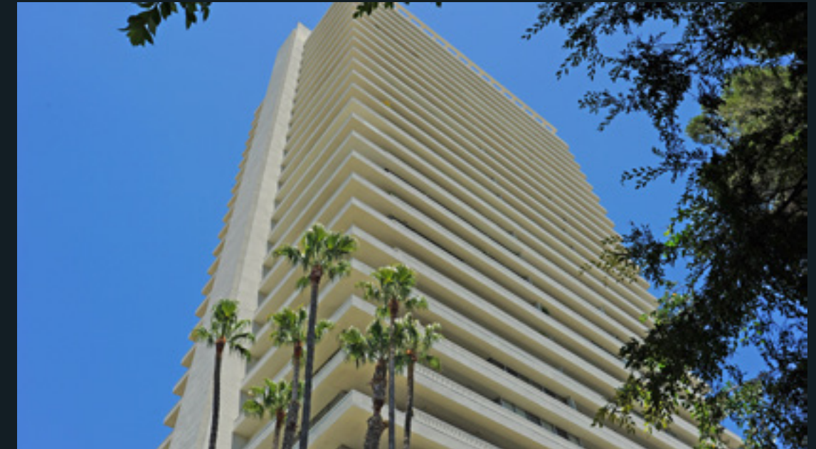
Sierra Towers Los Angeles, CA, USA.
